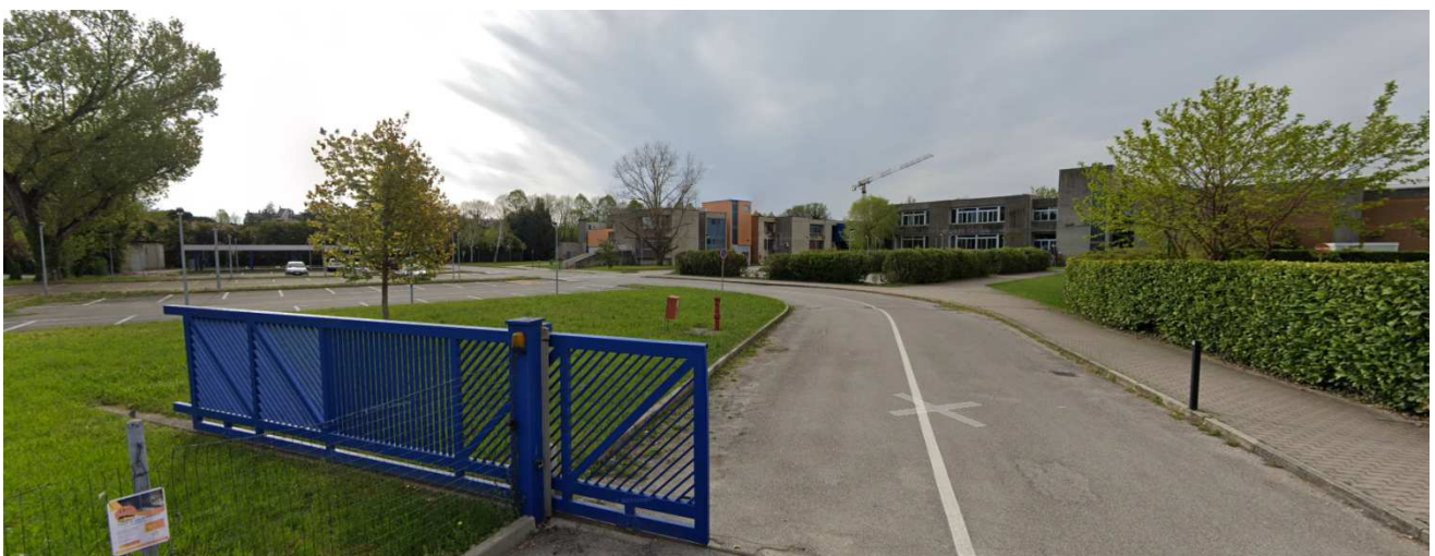
Recinzione e cancello ingresso Liceo “Ugo Morin”
