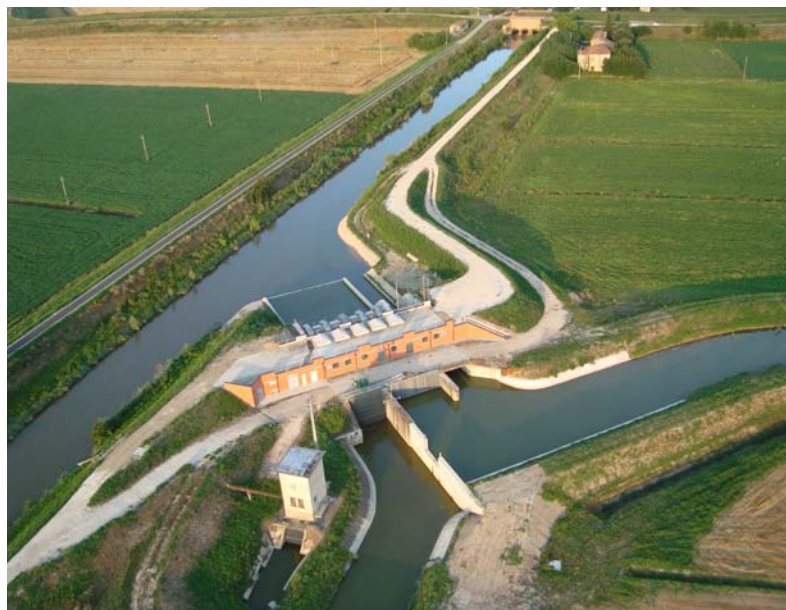
Idrovora nuova Frattesina
